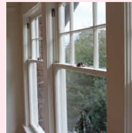
Pintura en ventanas de guillotina doble
