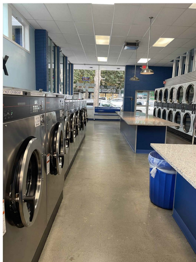
新裝之掃基防滑地板磚，地面高度最多變更 1/4"
