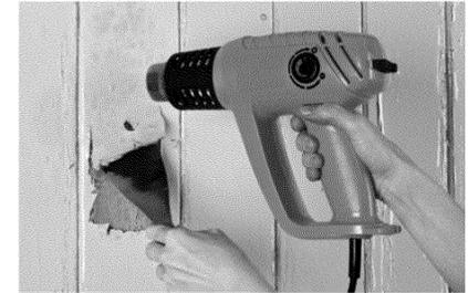
雖然無法完全消除粉塵，但有些翻新方法是可以減少粉塵。承包商可能會選擇運用不同的方式減少粉塵，包括在打磨或刮除油漆前以水噴灑油漆表面；分割組件前先刮除油漆；及以撬和扯斷的方式分割組件，而不採用破斷方法。
