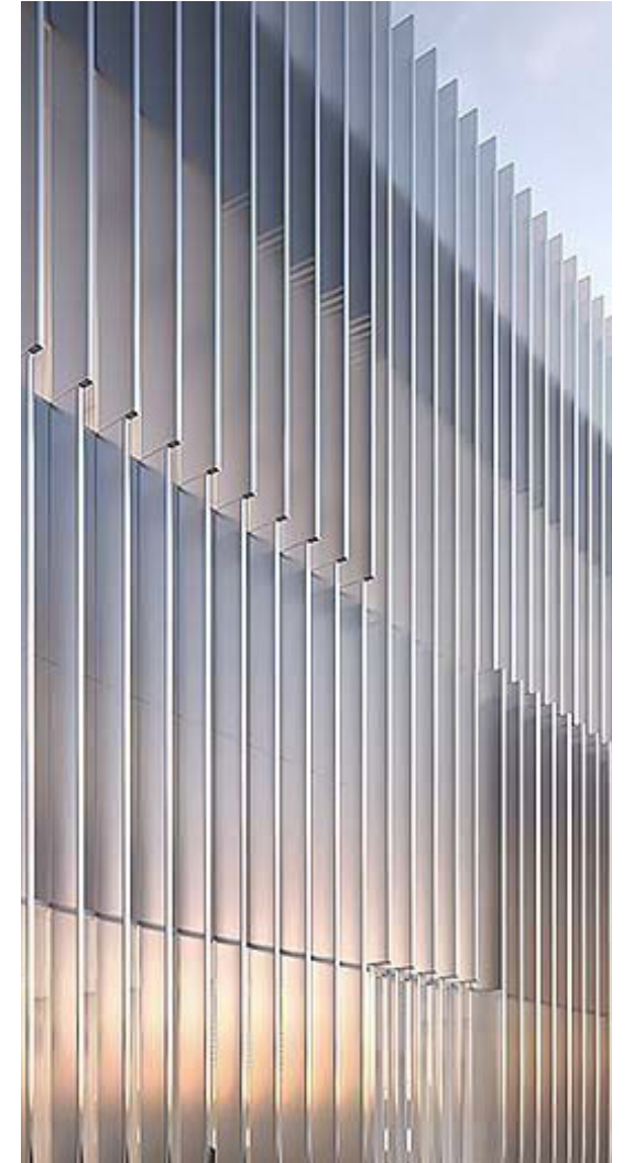
ALUMINUM FINNS AND PANELS LEVELS 5-7
